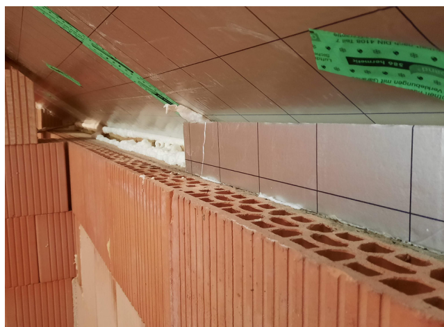
Obr. 5: Seřiznutí panelu u pozednice.
