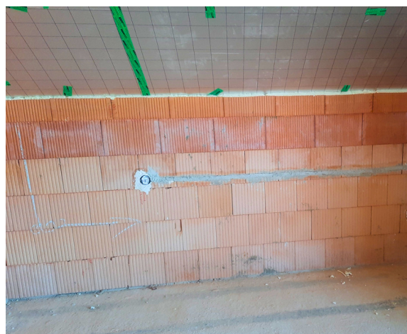
Obr. 6: Detail dozdnění a dopnění.
