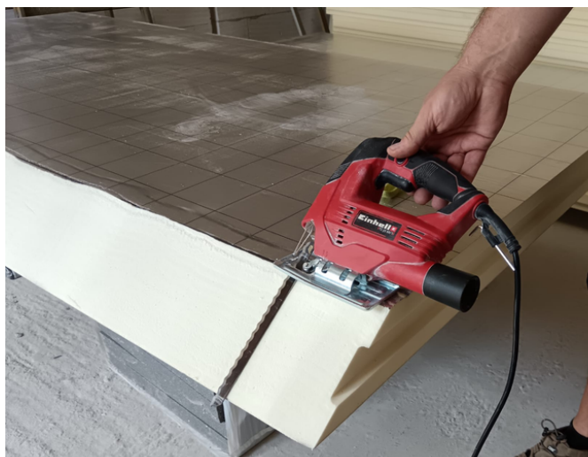
Obr. 4: Řezání PIR panelu pomocí přímočarky s dlouhým nožem.
