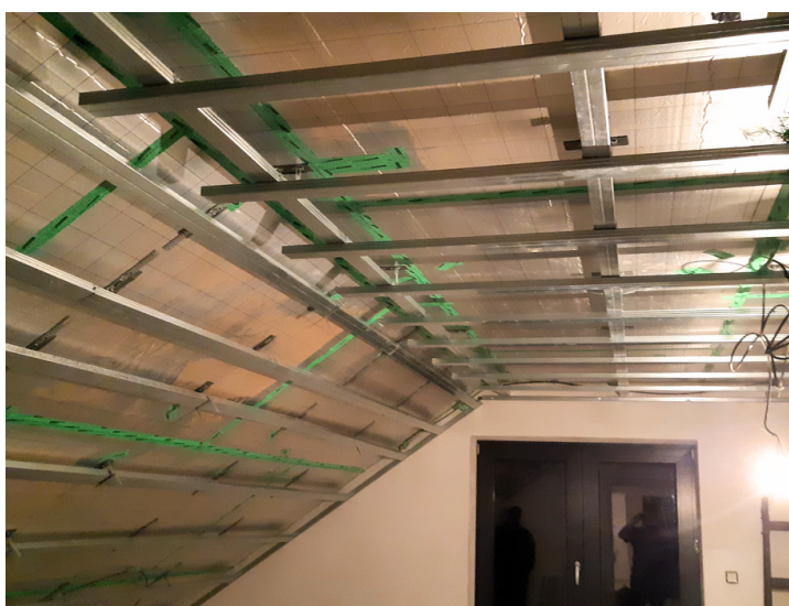
Obr. 9: Zateplení před záklopem z SDK.
