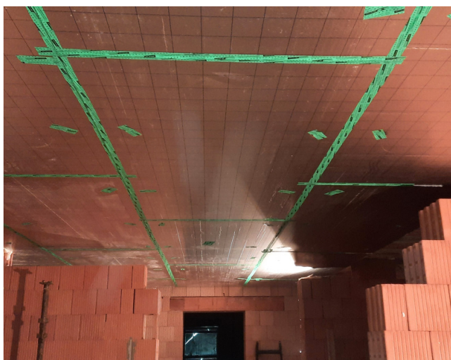
Obr. 7: Aplikace pásek, spoje panelů a kotevní body.
