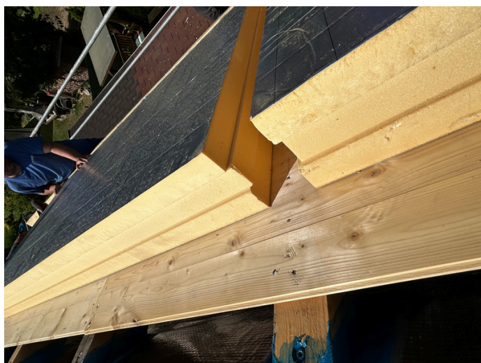
Pokládka PIR desek.
