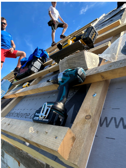
Kontralatě a latě.
