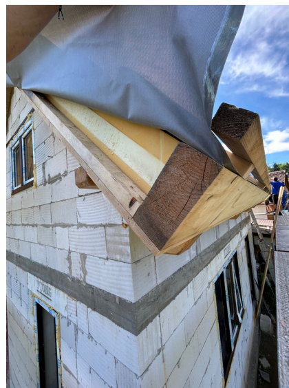
Zakládací hranol v tloušťce izolace.
