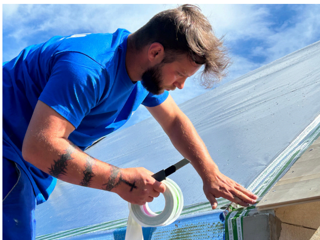
Parotěsné napojení na štítovou zeď.
