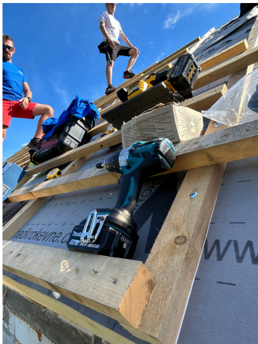
Kontralatě a latě.
