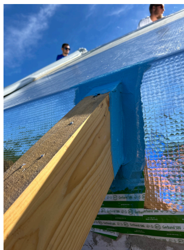
Parotěsné napojení na krov.
